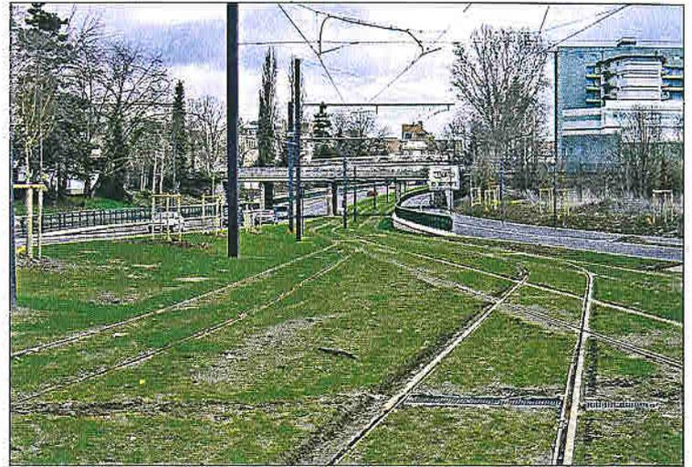
Abb. 13: Rond Point G. Stricker, Bd. Charles Stoessel. Hier wurden 3 x 3 Streifen durch 2 x 1 Streifen, eine breite Tramtrasse und breite Fahrrad- und Fußgängerwege ersetzt. Im Hintergrund die Eisenbahn Mulhouse-Strasbourg, vorn der künftige Tram-Train-Anschluss.
